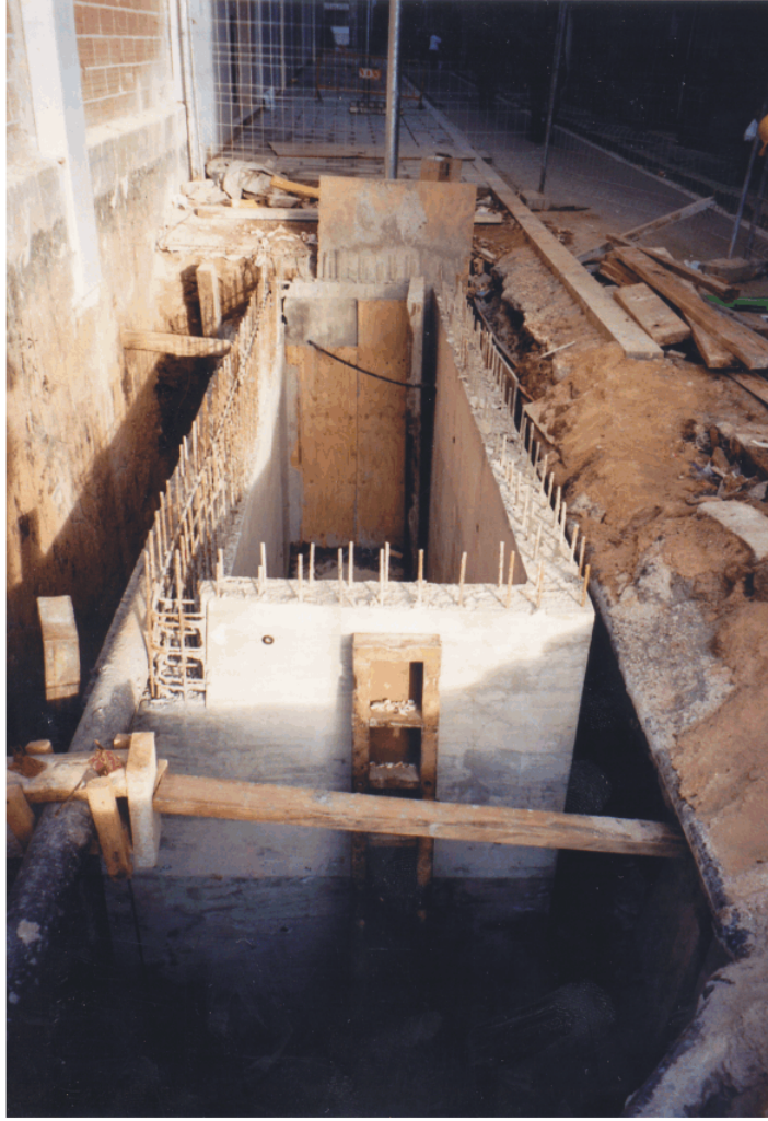
F.12- Vista de la RASA 5 després de l'excavació
