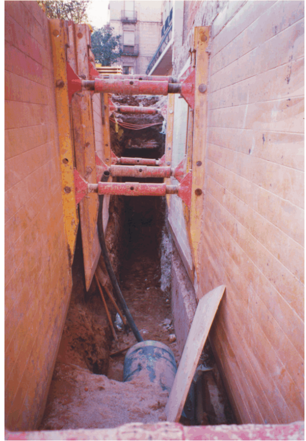
F.15 - RASA 8 amb els plafons de contenció de terres
